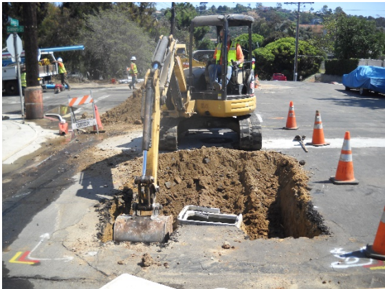
Meter Box Install
